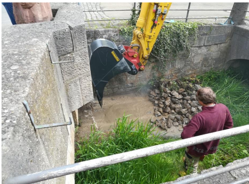
vorbereitende Maßnahmen zur Baugrunduntersuchung
