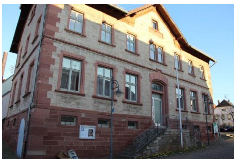
Erneuerung der Fenster am ehem. Rathaus in Distelhausen
