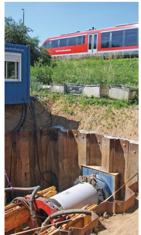
Oben rollt der Zug und unten werden die Rohre verlegt.
