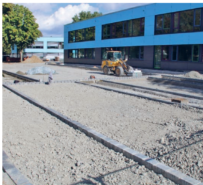
Hier entstehen Park- und Fahrradstellplätze.
