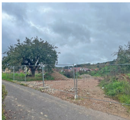
KiTa-Baugelände in Hochhausen
