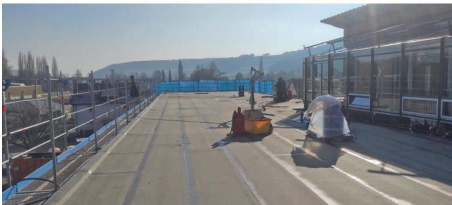
Dachdeckungsarbeiten: Ausführung der Dampfbremse
