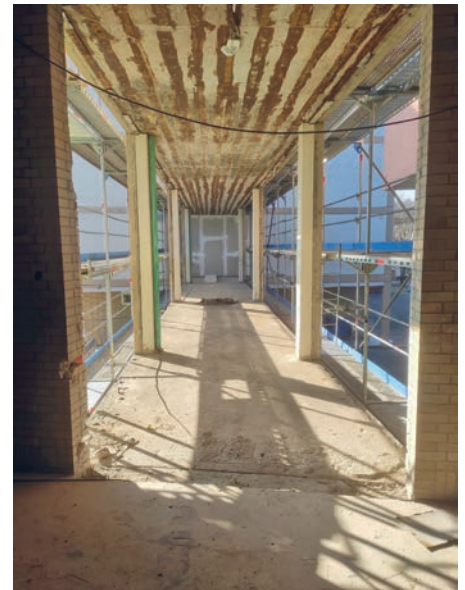
Blick auf den Verbindungsbau Richtung Großes Haus
