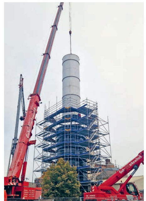
Der Faulturm hat ein neues Leitrohr bekommen und die Verfahrenstechnik ist angepasst.
