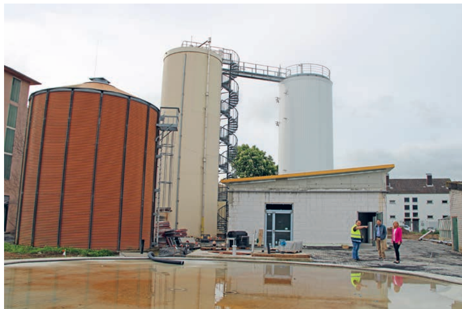
Der Faulturm ist saniert, das neue Betriebsgebäude steht und das Fundament für den neuen kuppelförmigen Gasspeicher ist vorbereitet.
