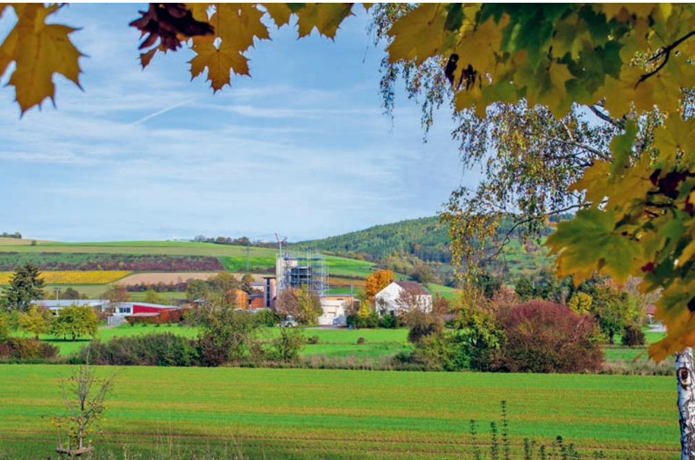
Im Herbst war der Faulturm noch im Baugerüst.
