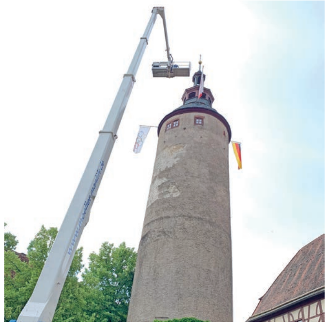
Der Türmersturm hat im Frühjahr eine Dachpflege bekommen.
